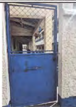
Foto 26: Mantenimiento a portones de metal, Modulo II
