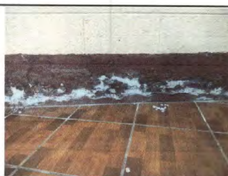
Foto 12: Pintura en muros exteriores e interiores
