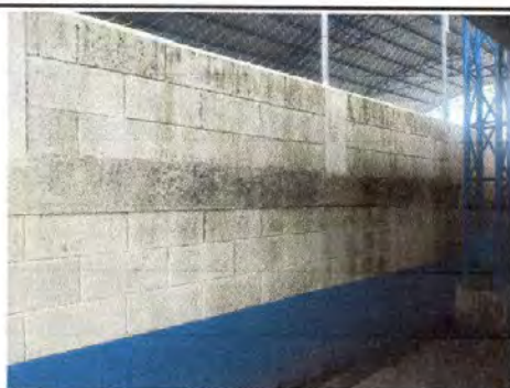
Foto 11: Pintura en muros exteriores e interiores
