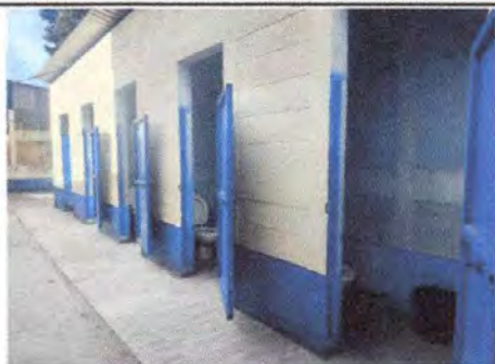
Foto 19: Sustitucion inodoro, Modulo I
