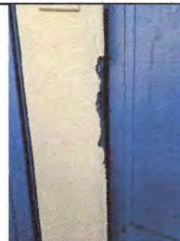
Foto 22: Remodelacion Servicios Sanitarios, Modulo I
