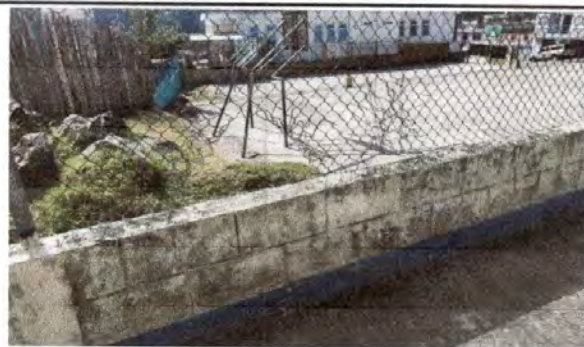
Foto 16: Reparación de muro perimetral de block con tubo hg y malla galvanizada
