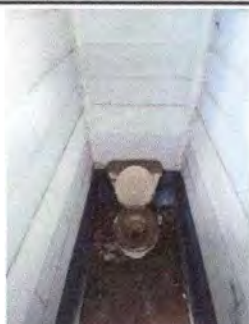
Foto 23: Sustitucion inodoro, Modulo I
