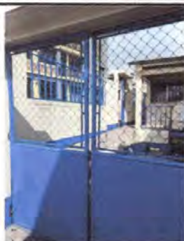
Foto 25: Mantenimiento a portones de metal, Modulo II
