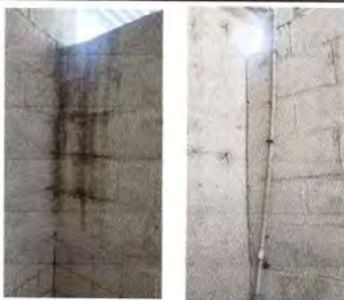
Foto 17: Pintura en muros exteriores e interiores
