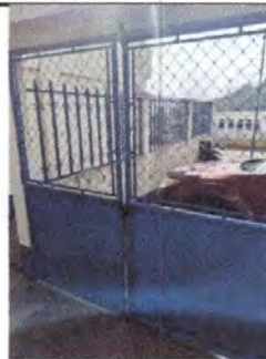
Foto 24: Mantenimiento a portones de metal, Modulo II
