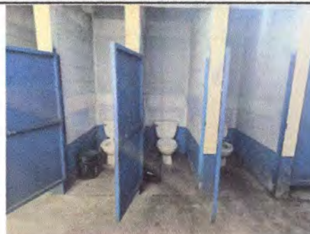
Foto 20: Sustitucion inodoro, Modulo I
