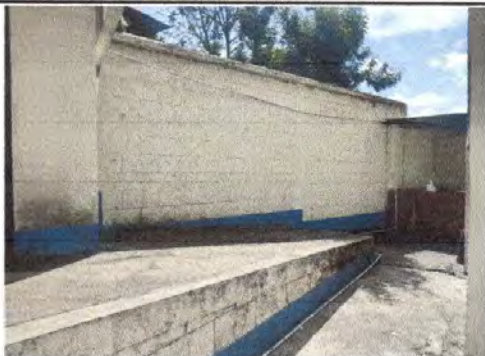
Foto7: Pintura en muros exteriores e interiores
