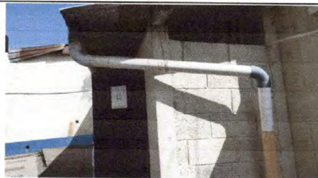
Foto 4: Reparacion de Red de Drenaje y Red de agua potable
