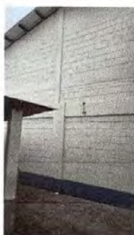
Foto 15: Pintura en muros exteriores e interiores
