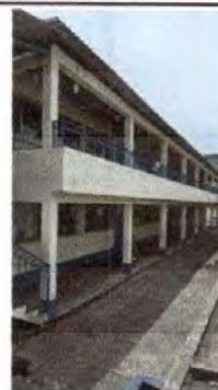
Foto 14: Pintura en muros exteriores e interiores
