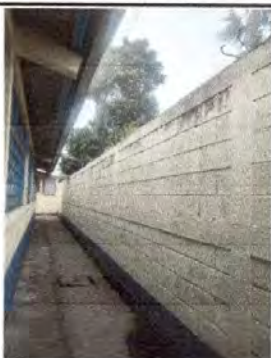
Foto 13: Pintura en muros exteriores e interiores
