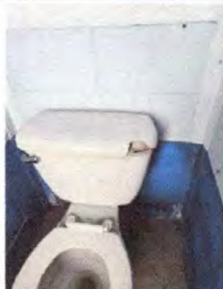
Foto 21: Sustitucion inodoro, Modulo I
